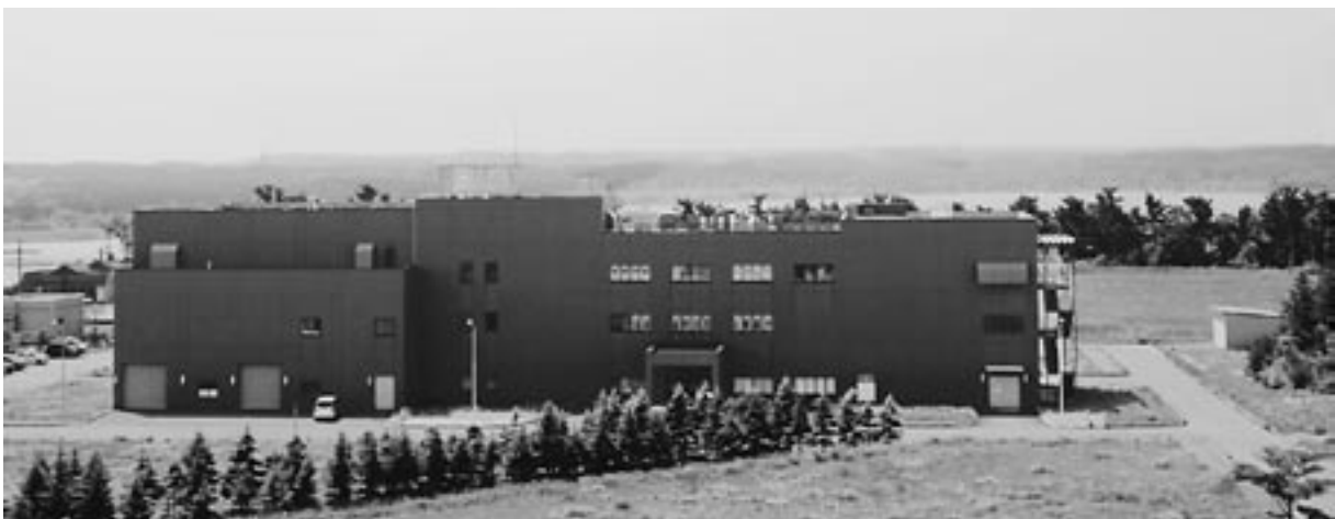
図1 全天候型人工気象実験施設(全景)
