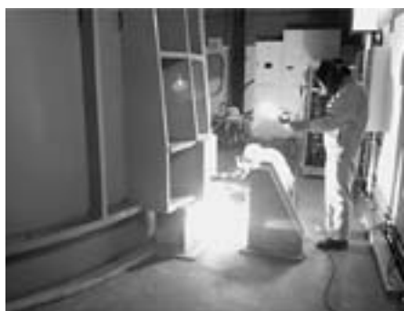
図5 加速器タンク固定作業 (4階支持台の溶接固定)
