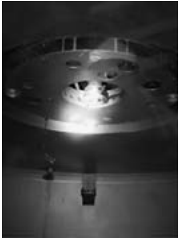
図2 加速器タンク最上部の第1ユニット取り付け箇所 (2011年3月23日確認)
