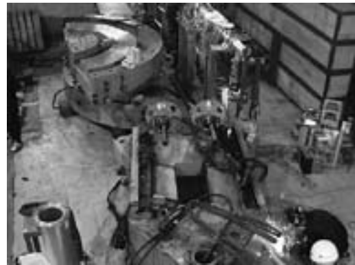
図2. 大型双極電磁石スペクトロメータ LDM の解体
