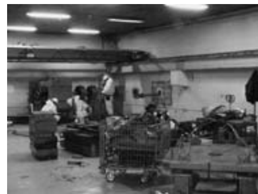
図3. 加速器解体撤去作業の様子
