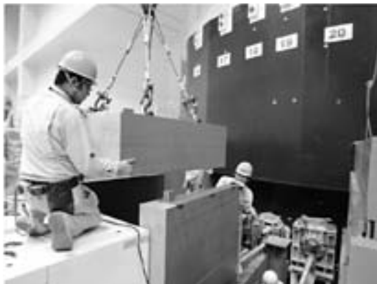
図3 中性子ターゲット前置遮蔽体復旧作業の様子
