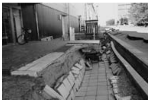
図 1 震災直後の LINAC 棟の様子
