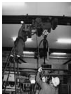
図6 9階に設置された クレーン(2トン) の修理作業
