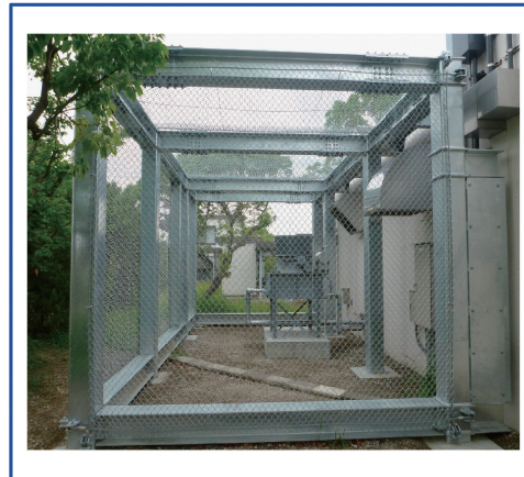
図5 非常用電源用屋外冷却塔の防護設備設置工事
