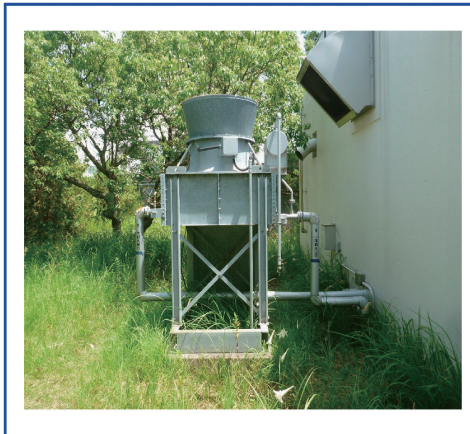
図5 非常用電源用屋外冷却塔の防護設備設置工事
